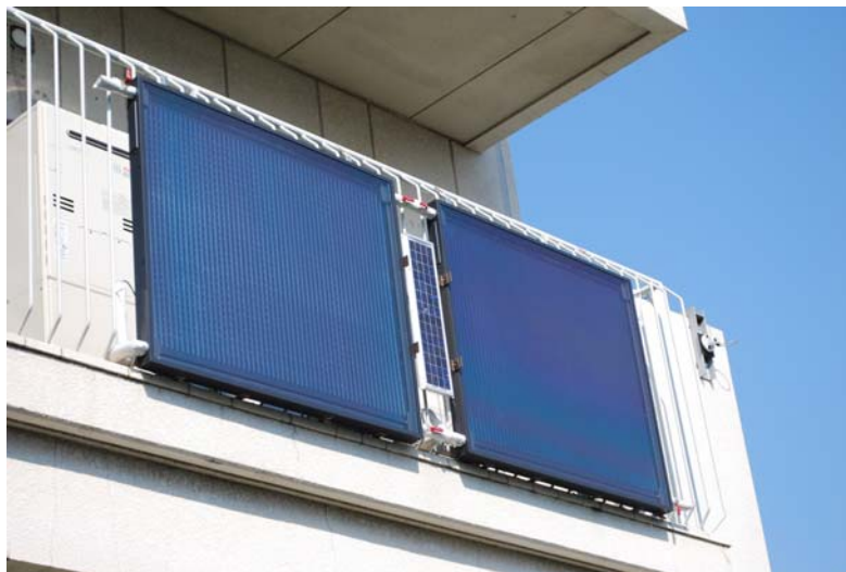
写真：次世代型ソーラー給湯システム (試作品、バルコニー手すり設置)
