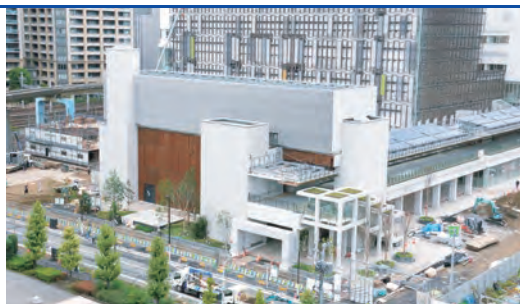
田町駅東口北地区I街区 第1スマートエネルギーセンター外観
