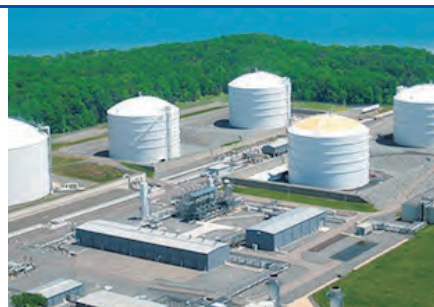
コーブポイントLNGプロジェクト
