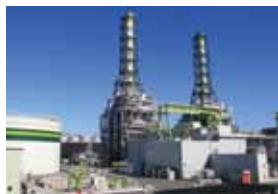
川崎天然ガス発電
