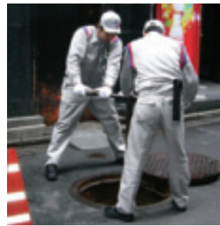
建物の大本のバルブを閉めて 点検を行います
