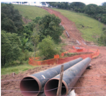
ブラジルにおける天然ガスパイプライン建設・運営事業「マーリャプロジェクト」
