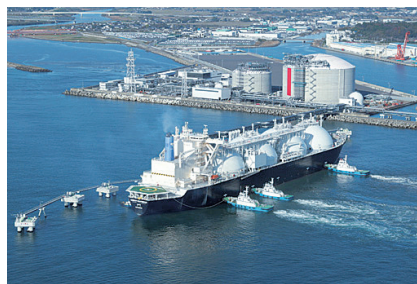
日立LNG基地
