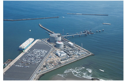
日立LNG基地
