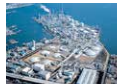
根岸LNG基地
