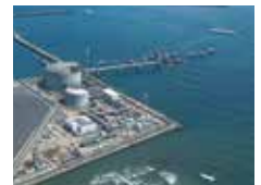
日立LNG基地
