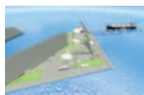
日立LNG基地(建設中)
