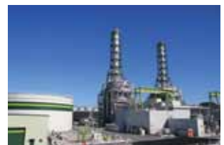
④ 川崎天然ガス発電
