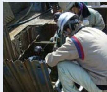
低圧の供給管の復旧作業
