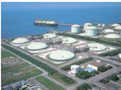
世界最大の袖ヶ浦LNG基地
