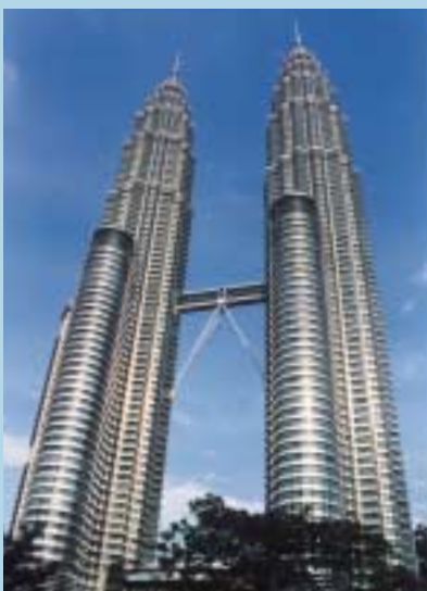
世界一の高さを誇るペトロナスツインタワーは東京ガスの技術援助のもと、ガス地域冷房システムを導入しました。
