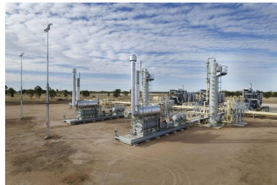
Queensland Curtis LNG Project (CBM Processing Plant)
