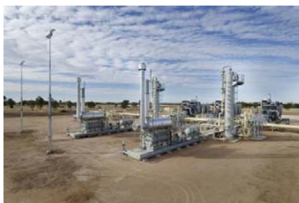
Queensland Curtis LNG Project (CBM Processing Plant)
