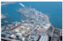
Negishi LNG Terminal
