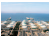
Sodegaura LNG Terminal
