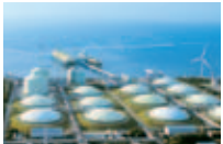
Sodegaura LNG Terminal
