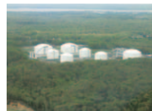
Cove Point LNG Project
