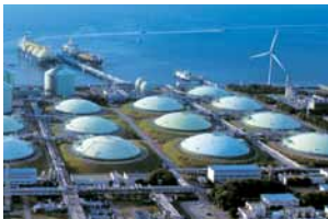
1 Sodegaura LNG Terminal
