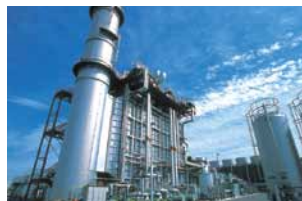
2 Tokyo Gas Baypower Co., Ltd.
