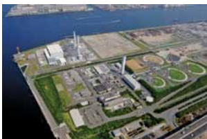
2 Ohgishima LNG Terminal
