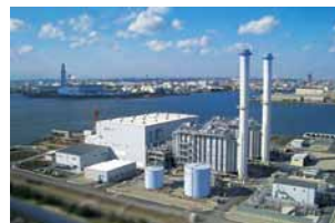
3 Ohgishima Power Co., Ltd.
