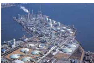
3 Negishi LNG Terminal
