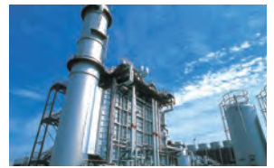
Tokyo Gas Baypower Co., Ltd.
