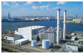
Ohgishima Power Co., Ltd.
