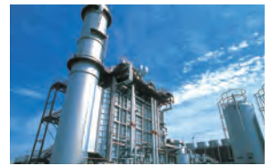
Tokyo Gas Baypower Co., Ltd.
